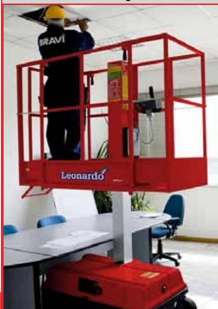
монтажные, отделочные работы
